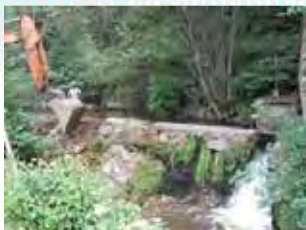
Démantèlement d'ouvrage hydraulique.
