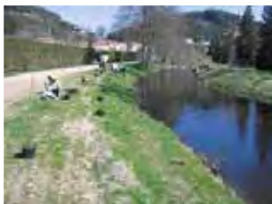
Chantier de protection de berge par des techniques de génie végétal.
