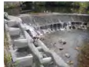
Aménagement de passe à poissons à bassins successifs.
